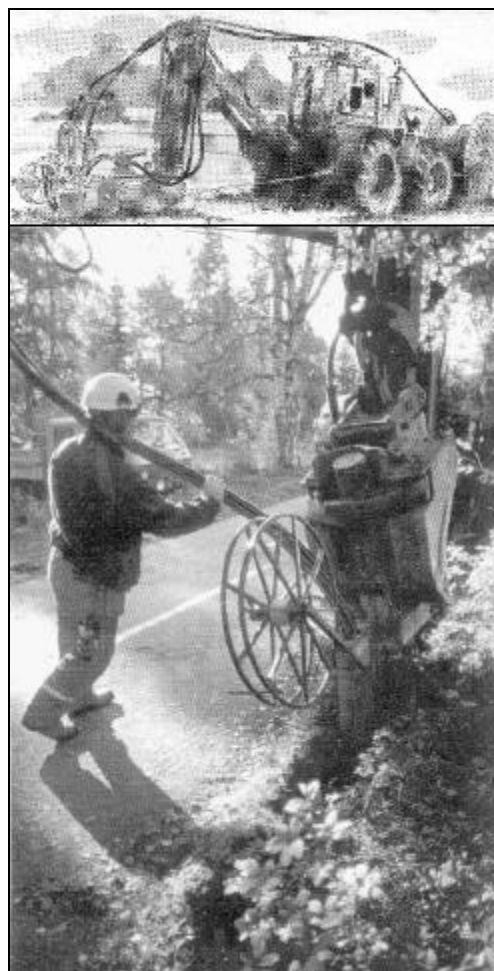
Plöjning av kanaler (plastslang) för optokabel. 83
