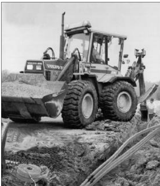
Schaktning av kanaler för optokabel. 85
